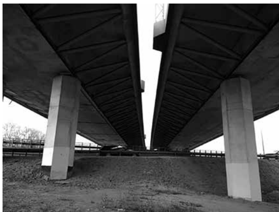
Zdj. 1. Przykład przecinania się autostrady A8 (wyżej) z drogą krajową 94 (niżej) nieopodal Stadionu Miejskiego we Wrocławiu; fot. Paweł Majczak
